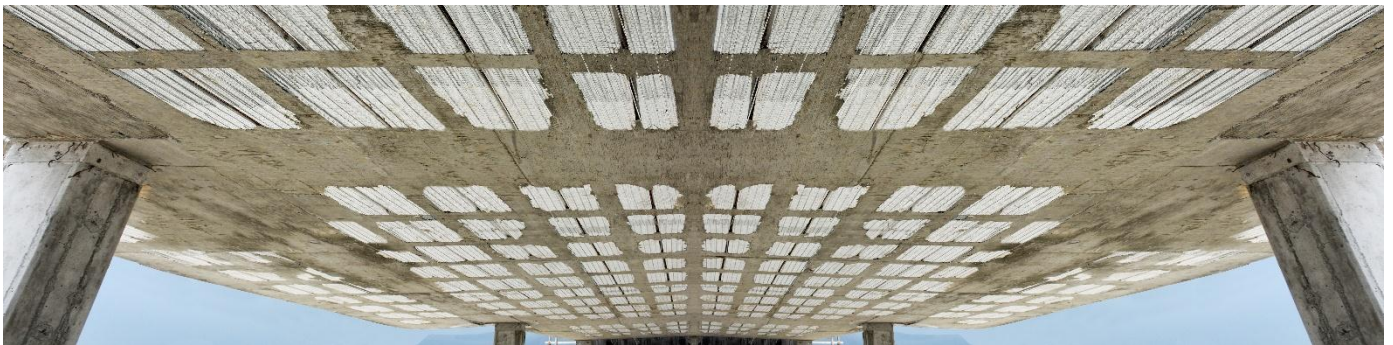
شکل ۷-۵ سقف اجرا شده به قالب کانتراس وافل
